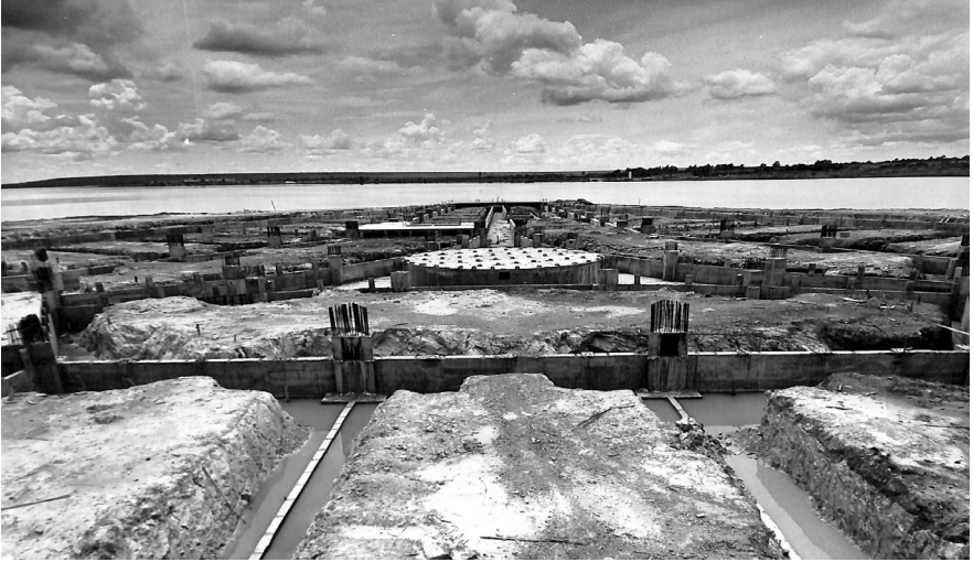
Figura 2 — Fundações da ESG (Brasília). Fonte: SDMI/ESG. 1974 [Autor não identificado].
